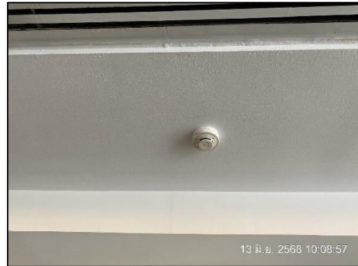
ภาพที่ 36 เครื่องตรวจจับความร้อน (Heat Detector) / เครื่องตรวจจับควัน (Smoke Detector)
