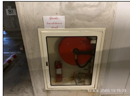
ภาพที่ 30 ตู้เก็บสายฉีดน้ำดับเพลิง
