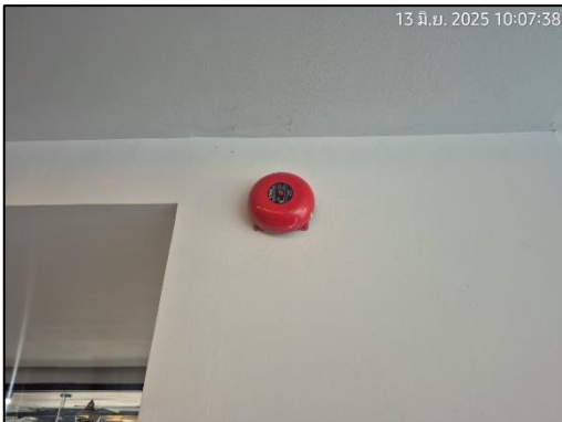
ภาพที่ 37 กริ่งสัญญาณ (Fire Alarm)
